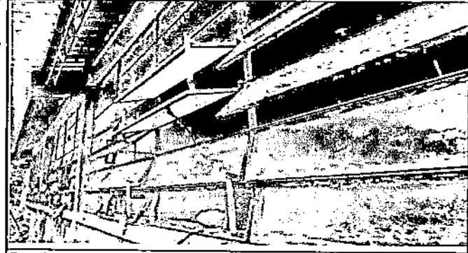
Foto 1: Fabricacion e Instalacion de balcones de hierro en ventana
