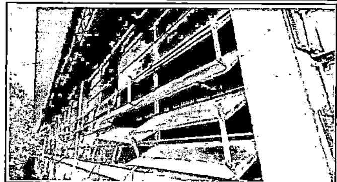
Foto 2: Fabricacion e Instalacion de balcones de hierro en ventana
